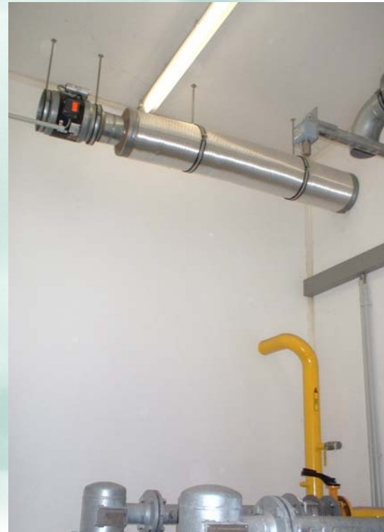
Raumluftüberwachung im Abluftstrom
