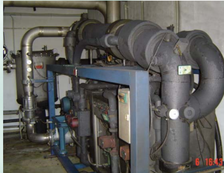
Gaskühlung zur Kondensatabscheidung
