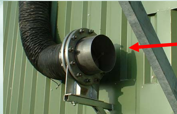
Austritt der Luft zum Aufblasen des Fermenterdachs
