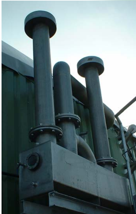
Überdruck-/Unterdrucksicherung am Fermenter
