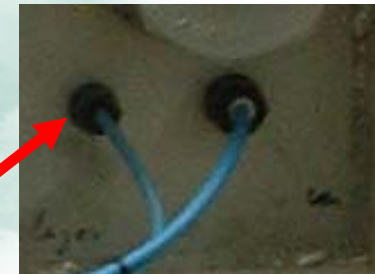
Durchführungen durch die Fermenterwand
