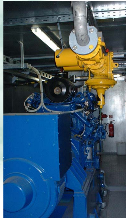
Gasmotor und Generator
