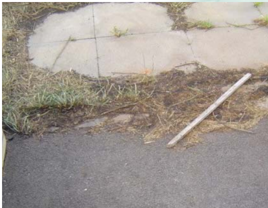
Brandspuren vor dem Gebäude
